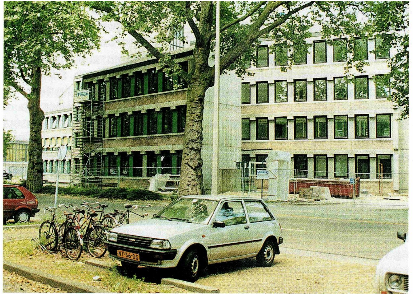
Gedeeltelijk verbouwd; kleur en zonneschermen weg.
